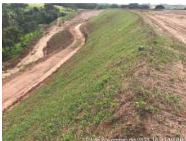
Foto 241 – Leira para retenção de material e disciplinamento do fluxo para as caixas de retenção. Bota Fora 01 (Data: 23/11/2021)
