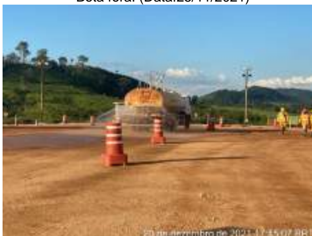
Foto 346 – Umectação de vias internas. (Data:20/12/2021)
