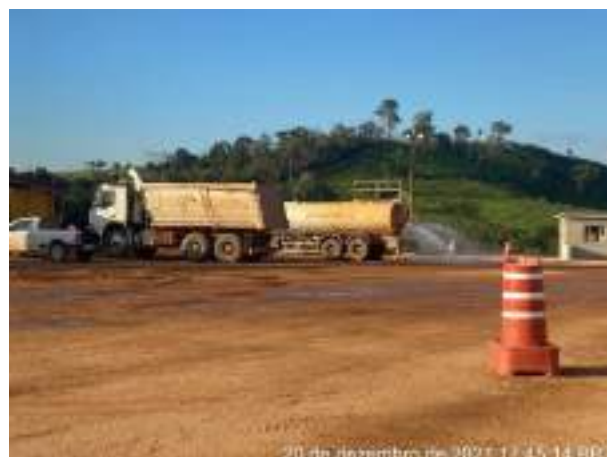
Foto 349 – Umectação de vias internas, industrial. (Data:20/12/2021)
