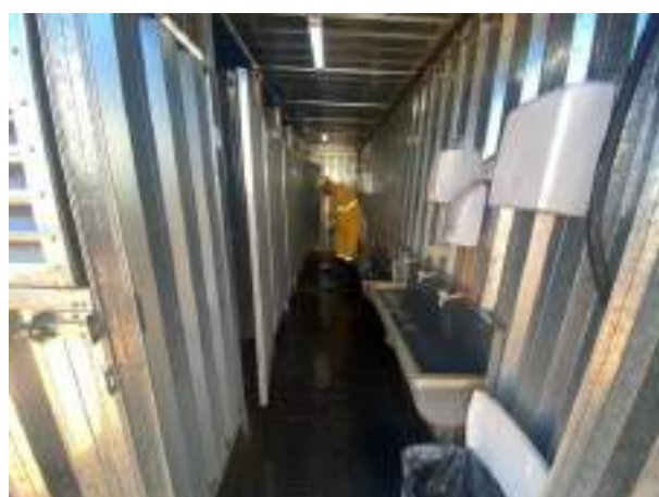
Foto 116 – Limpeza do sanitário no canteiro industrial. (Data:12/01/2022)
