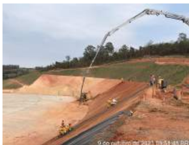
Foto 290 – Concretagem das canaletas de drenagem. (Data: 09/10/2021)
