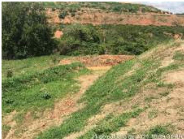
Foto 266 – Vista para a cacimba de retenção de sólidos com vegetação estabelecida na borda. (Data: 21/10/2021)
