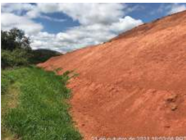
Foto 223 – Canaleta e leira no entorno da bota espera. (Data:21/10/2021)
