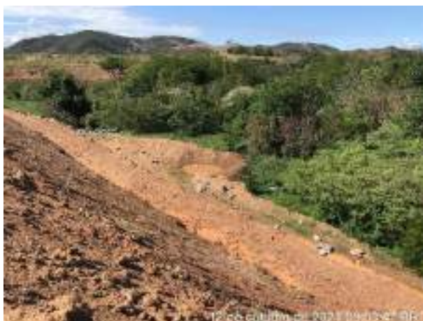
Foto 260 – Vista para cacimba, leiras e solo vegetal. (Data: 12/10/2021)
