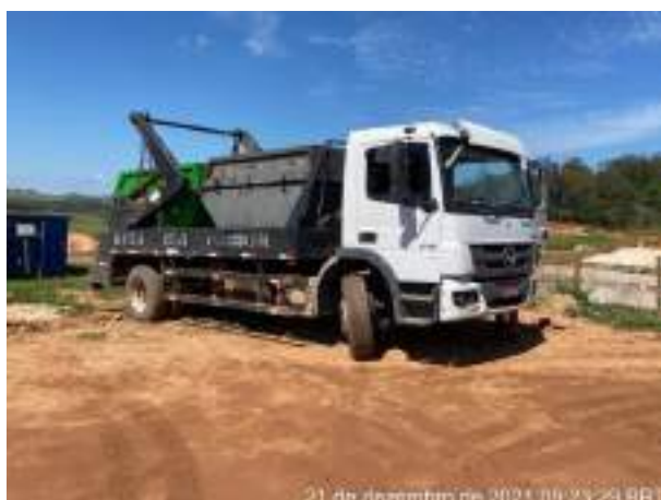
Foto 378 – Troca de caçambas de resíduos do canteiro industrial. (Data:21/12/2021)
