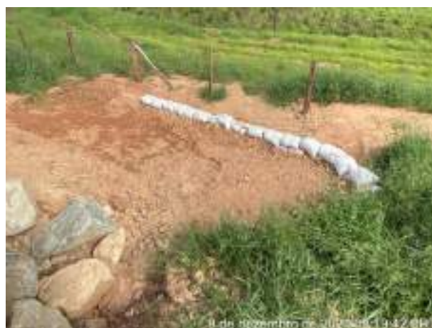
Foto 311 – Implantação de dispositivos de drenagem próximo ao canteiro industrial.
