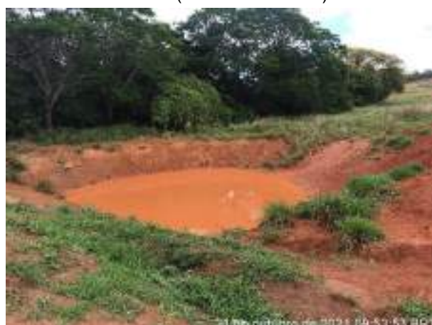
Foto 227 – Cacimba de retenção de particulado. (Data:21/10/2021)
