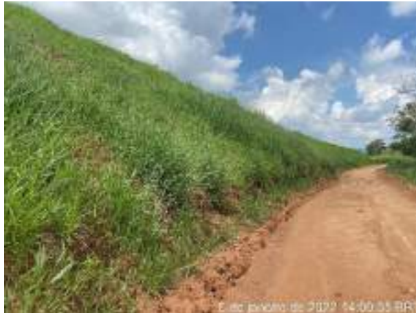
Foto 255 – Cobertura vegetal, leira e canaletão. (Data: 06/01/2022)
