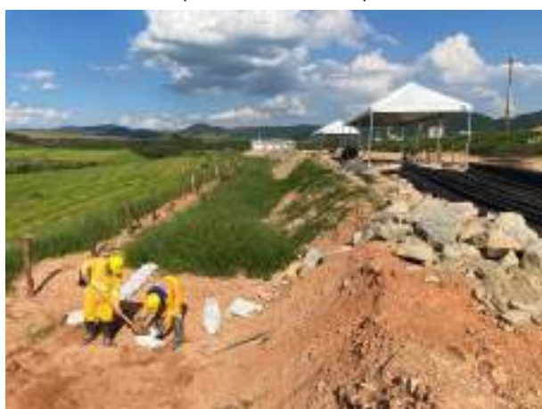
Foto 312 – Implantação de barreiras tipo rip rap (Data:06/12/2021)
