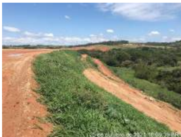
Foto 235 – Leira para retenção de material e disciplinamento do fluxo para as caixas de retenção. Bota Fora 01 (Data: 31/10/2021)
