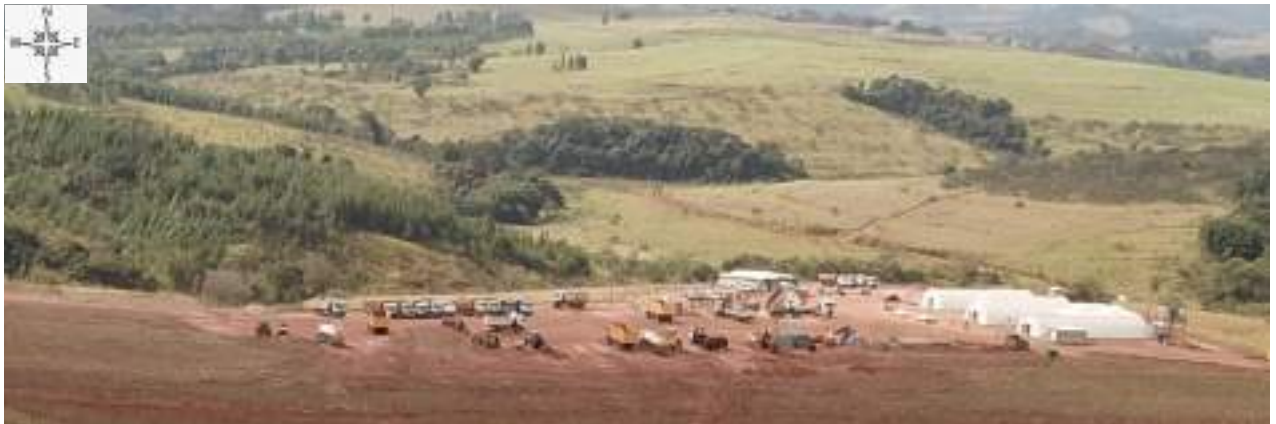
Foto 299 – Canteiro industrial. (Ilustrativo)
