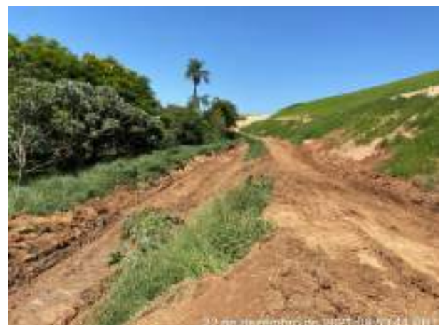
Foto 248 – Leira e canaletão para retenção de material e disciplinamento do fluxo para as caixas de retenção. (Data: 22/12/2021)
