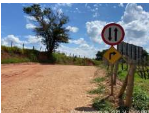
Foto 197 – Via municipal de acesso a obra. (Data:06/12/2021)
