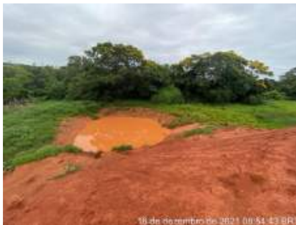
Foto 210 – Vista para inclinação e direcionamento do platô. Leira de solo entre as bermas do talude do bota espera. (Data:16/12/2021)
