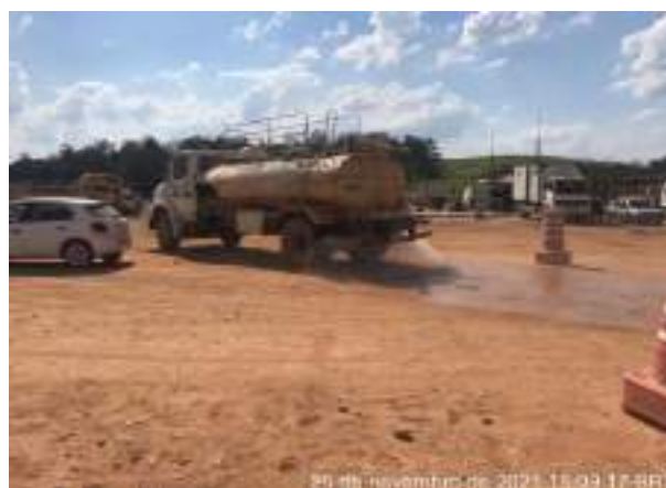
Foto 345 – Umectação de vias internas, industrial. (Data:25/11/2021)
