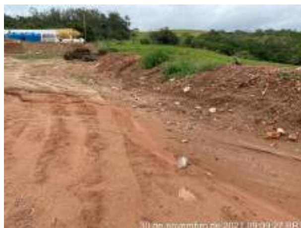
Foto 309 – Vista para área sem riscos. (Data:30/11/2021)
