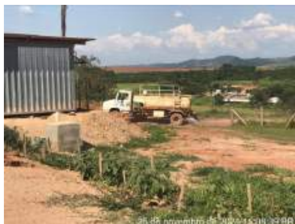
Foto 343 – Umectação de vias internas, industrial. (Data: 25/11/2021)
