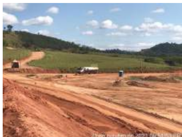
Foto 341 – Umectação de vias internas, MD vertedouro. (Data:21/10/2021)
