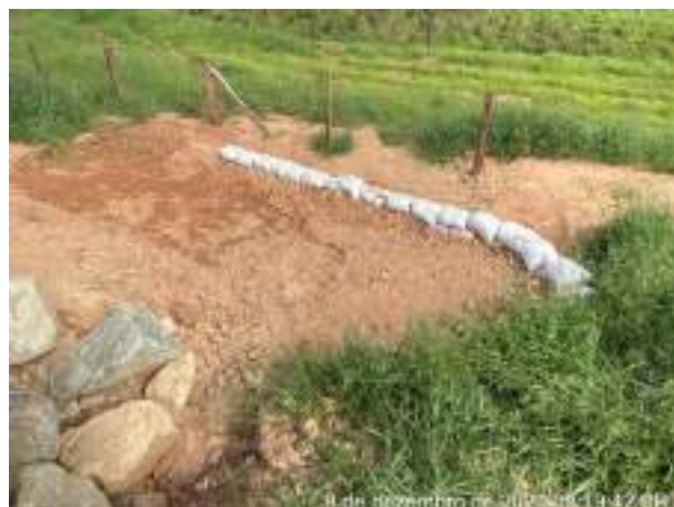
Foto 294 – Implantação de dispositivos de drenagem próximo ao canteiro industrial. (Data:08/12/2021)
