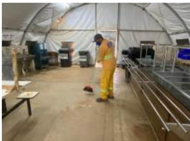
Foto 115 – Limpeza do refeitório do canteiro industrial. (Data:26/01/2022)
