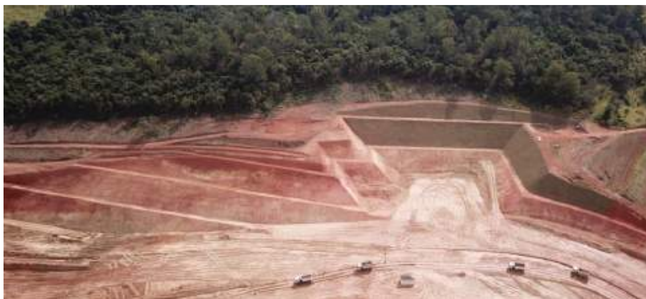
Foto 286 – Talude do Vertedouro. (Ilustrativo)
