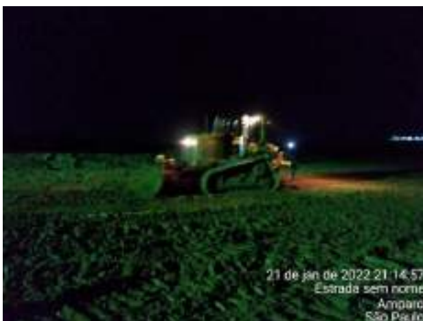
Foto 117 – Movimentação de terra Bota Fora. (Data:21/01/2022)
