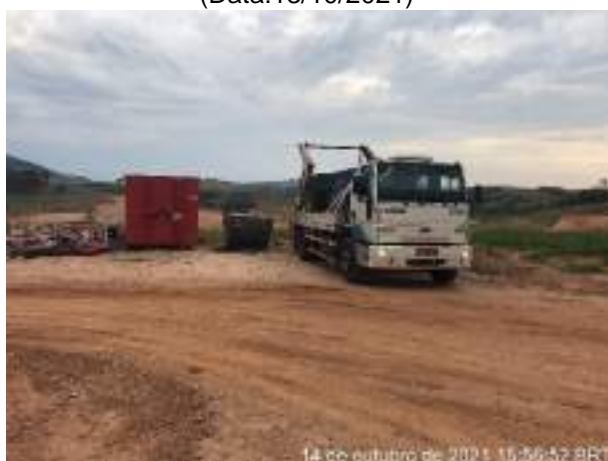
Foto 366 – Troca da caçamba de metal do canteiro industrial. (Data:14/10/2021)
