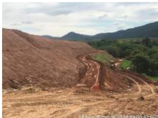
Foto 240 – Solo vegetal, leira e disciplinamento para caixas de retenção. (Data: 27/10/2021)
