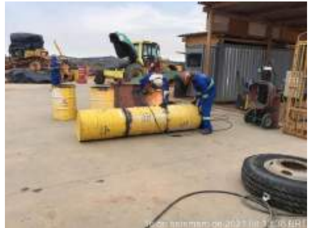
Foto 136 – Solda dos tambores. (Data:20/10/2021)
