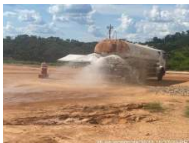
Foto 353 – Umectação de vias internas, industrial. (Data:25/01/2022)
