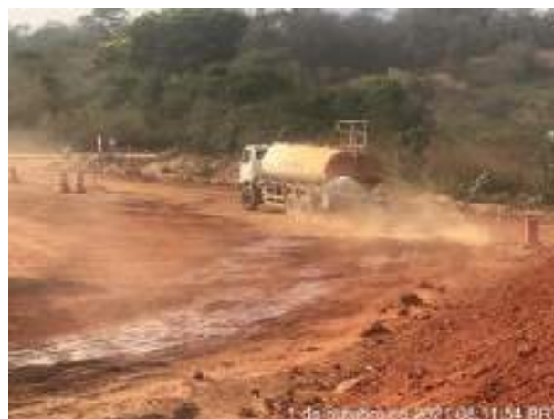
Foto 339 – Umectação de vias internas, ME galeria. (Data: 01/10/2021)
