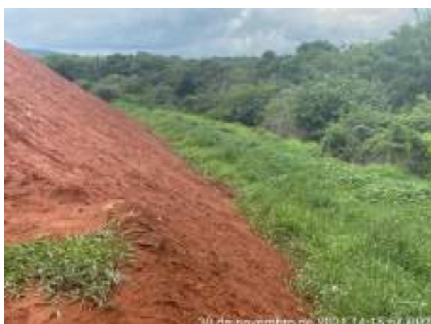
Foto 220 – Vista para inclinação e direcionamento do platô. Leira de solo entre as bermas do talude do bota espera. (Data:30/11/2021)
