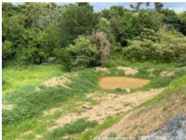
Foto 278 – Vista para a cacimba de retenção de sólidos com vegetação estabelecida na borda. (Data: 07/12/2021)
