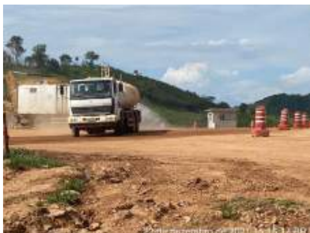
Foto 348 – Umectação das vias internas, industrial. (Data:22/12/2021)
