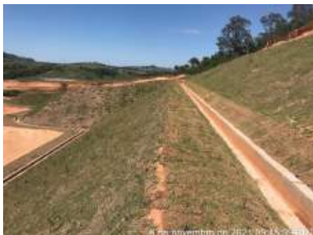
Foto 291 – canaletas de drenagem. (Data:01/11/2021)
