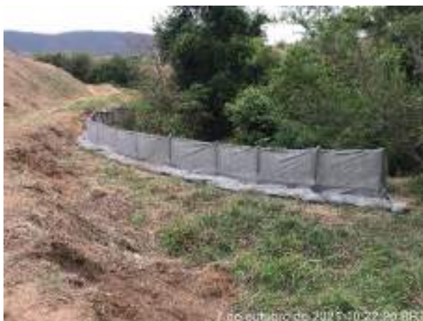
Foto 262 – Vista para barreira silt fence para proteção do corpo d'água. (Data: 07/10/2021)
