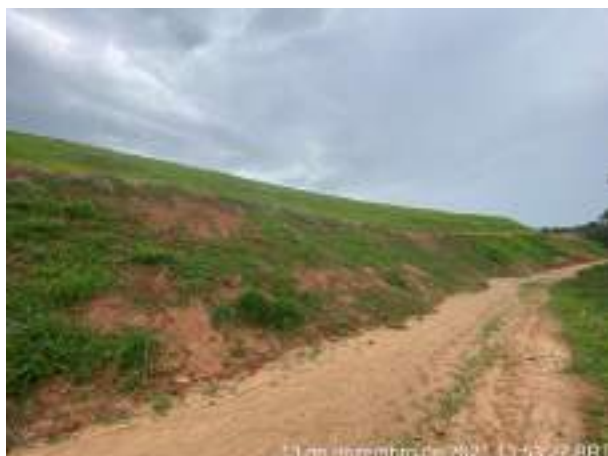
Foto 249 – Cobertura vegetal, leira e canaletão para retenção de material e disciplinamento do fluxo para as caixas de retenção. (Data:13/12/2021)
