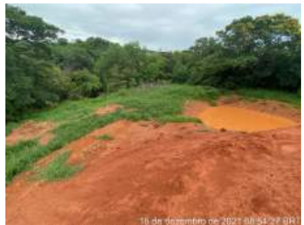
Foto 211 – Cacimba de retenção de particulado (Data:16/12/2021)
