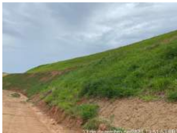
Foto 250 – Leira e canaletão para retenção de material e disciplinamento do fluxo para as caixas de retenção. (Data:13/12/2021)
