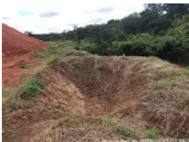
Foto 226 – Cacimba de retenção de particulado. (Data:21/10/2021)
