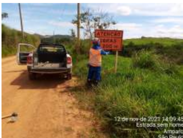
Foto 195 – Via municipal de acesso a obra. (Data:12/11/2021)
