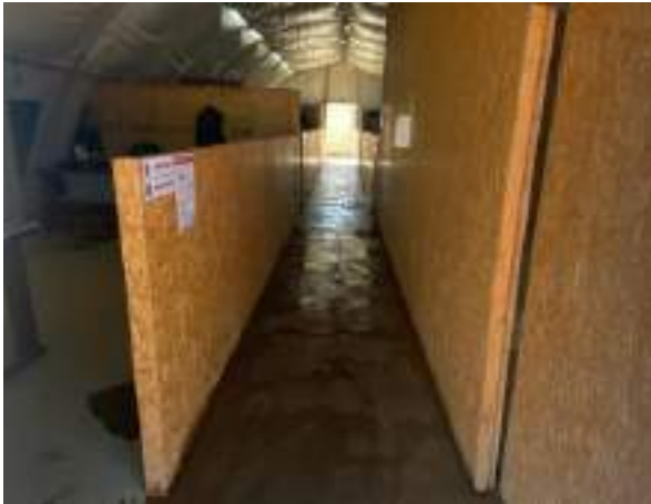
Foto 119 – Limpeza do escritório no canteiro industrial. (Data:18/01/2022)
