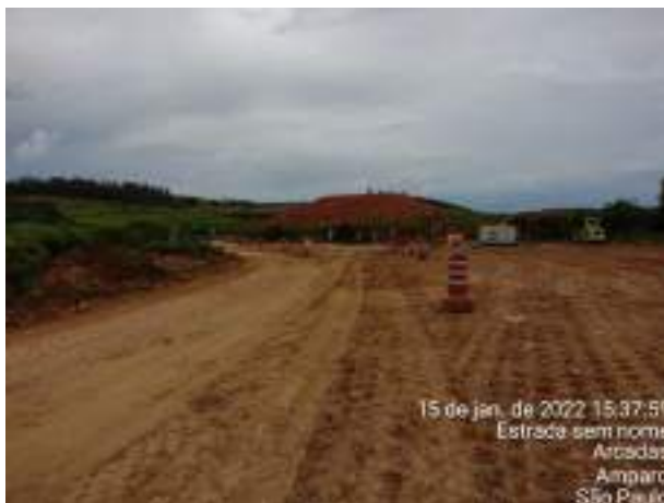
Foto 207 – Sinalização do acesso interno da Obra. (Data: 15/01/2021)
