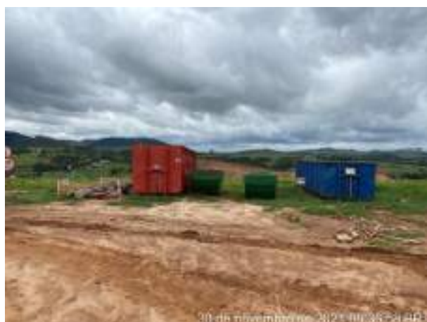
Foto 370 – Caçambas de resíduos no canteiro industrial. (Data:30/11/2021)
