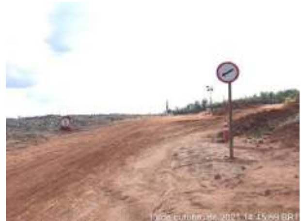
Foto 202 – Sinalização do acesso interno da Obra. (Data: 13/10/2021)
