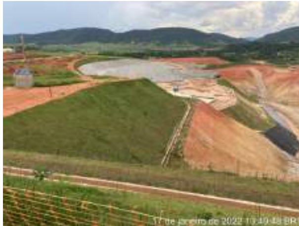
Foto 297 – Canaletas de drenagem. (Data:17/01/2022)
