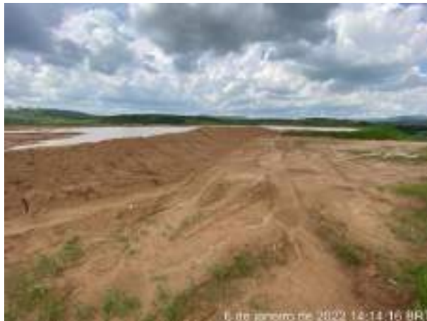
Foto 257 – Barreira de retenção de sedimentos no plato do Bota fora (Data: 06/01/2022)
