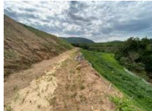
Foto 273 – Vista para solo com material vegetal germinando, leira e canaletas. (Data: 29/11/2021)
