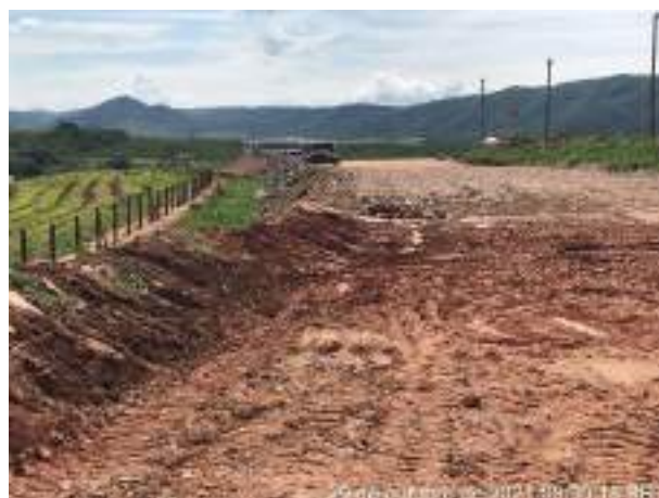
Foto 303 – Vista para área sem riscos. (Data:29/10/2021)
