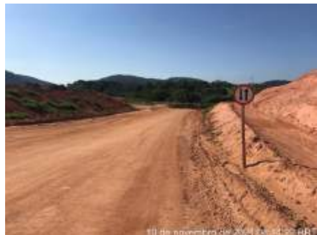
Foto 204 – Sinalização do acesso interno da Obra. (Data: 10/11/2021)
