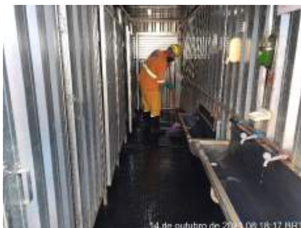
Foto 99 – Limpeza do banheiro no canteiro industrial. (Data:14/10/2021)
