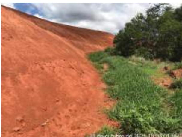
Foto 222 – Vista para inclinação e direcionamento do platô. Leira de solo entre as bermas do talude do bota espera. Data:21/10/2021)
