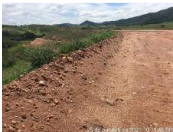
Foto 236 – Leira e canaletão para retenção de material e disciplinamento do fluxo para as caixas de retenção. (Data: 31/10/2021)
