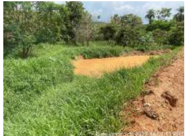
Foto 258 – Destaque para cacimbas de retenção de sedimentos após chuva. (Data: 06/01/2022)
