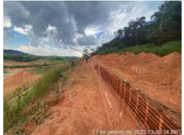
Foto 298 – canaleta de drenagem. (Data:17/01/2022)
