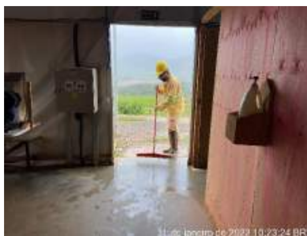
Foto 118 – Limpeza do refeitório do canteiro industrial. (Data:31/01/2022)
