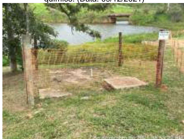
Foto 335 – Biodigestores do canteiro Administrativo. (Data: 07/12/2021)
