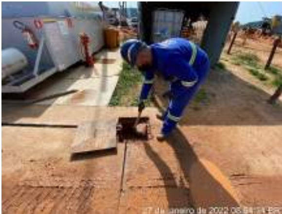
Foto 322 – Limpeza da Caixa SAO do tanque de combustível. (Data: 27/01/2022)
