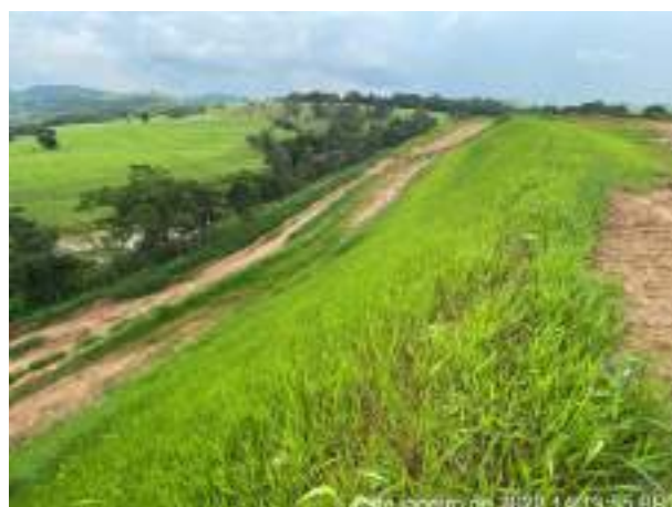
Foto 254 – Leira e canaletão para retenção de material e disciplinamento do fluxo para as caixas de retenção. (Data: 06/01/2022)
