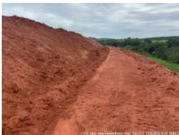
Foto 212 – Vista para inclinação e direcionamento do platô. Leira entre as bermas. (Data: 16/12/2021)
