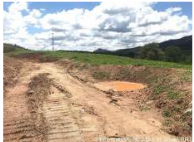
Foto 267 – Vista para a cacimba de retenção de sólidos com vegetação estabelecida na borda. (Data: 21/10/2021)
