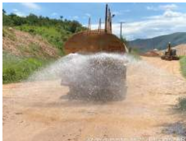
Foto 347 – Umectação de vias internas, Bota fora. (Data: 22/12/2021)
