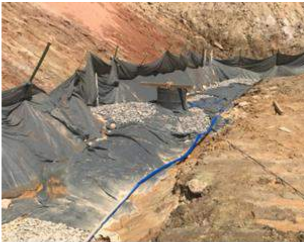
Foto 141 – Dreno com bidim no local de utilização. (Data:20/11/2021)
