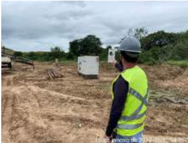
Foto 360 – Inspeção de fumaça preta do Gerador. (Data:10/01/2022)
