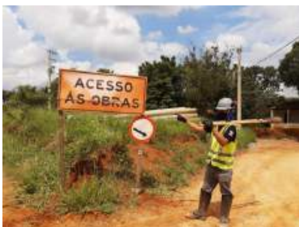
Foto 199 – Via municipal de acesso a obra. (Data:12/01/2022)
