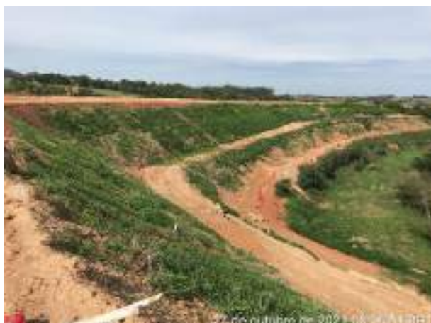
Foto 237 – Cobertura vegetal, leira e canaletão para retenção de material e disciplinamento do fluxo para as caixas de retenção. (Data:27/10/2021)
