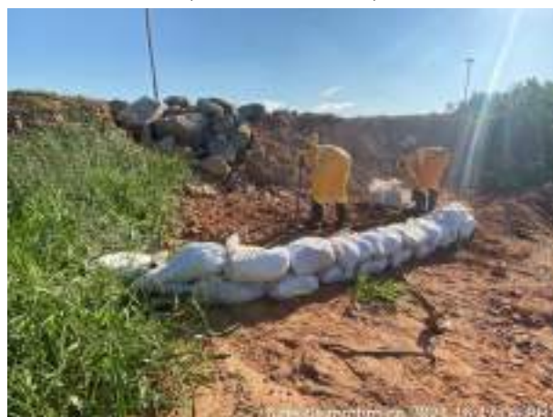
Foto 296 – Implantação do sistema rip rap. (Data:06/12/2021)
