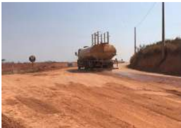
Foto 342 – Umectação de vias internas. (Data:16/11/2021)
