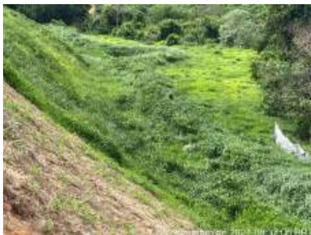
Foto 276 – Vista para a cacimba de retenção de sólidos com vegetação estabelecida na borda. (Data:07/12/2021).
