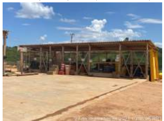
Foto 86 – Baia para armazenamento de produto químico. (Data:27/12/2021)
