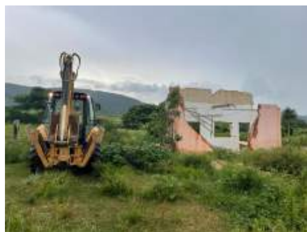
Foto 118 – Demolição casa 17 Ypê. (Data:28/01/2022)
