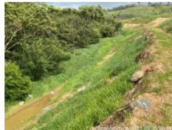
Foto 279 – Vista para solo com material vegetal germinando, leira e canaletas. (Data: 07/12/2021)
