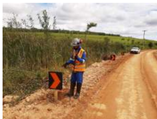
Foto 200 – Via municipal de acesso a obra. (Data:12/01/2022)
