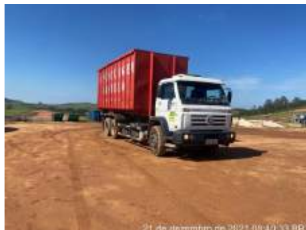
Foto 375 – Troca da caçamba de resíduo de madeira do canteiro industrial. (Data:21/12/2021).
