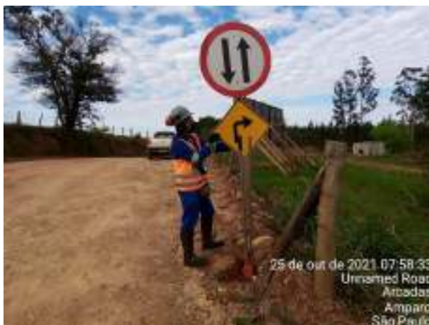
Foto 193 – Via municipal de acesso a obra. (Data:25/10/2021)
