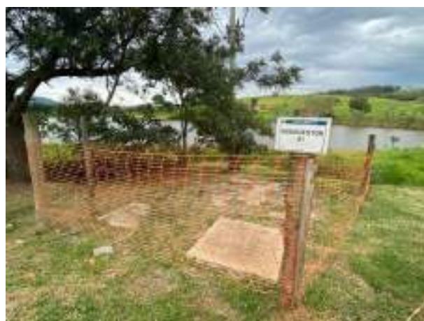
Foto 331 – Biodigestores do canteiro Administrativo. (Data: 14/11/2021)
