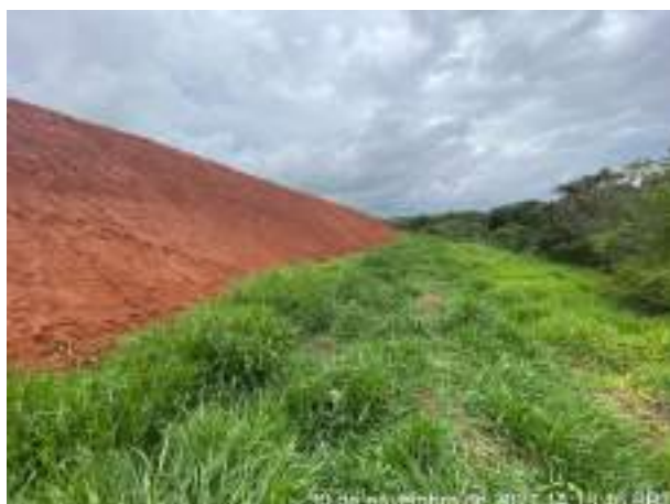
Foto 218 – Canaleta e leira no entorno da bota espera. (Data:30/11/2021)
