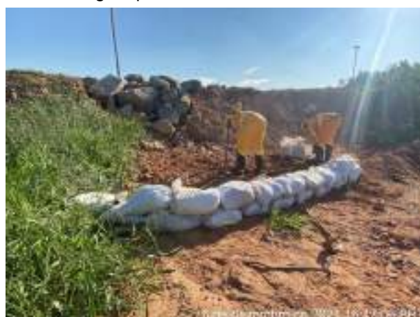
Foto 313 – Implantação do sistema rip rap. (Data:06/12/2021)
