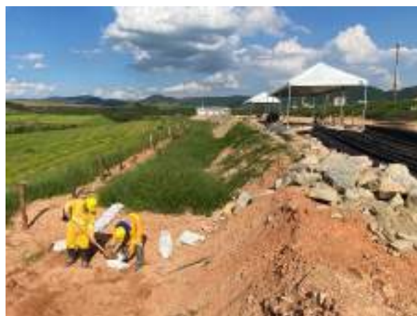
Foto 315 – Implantação de dispositivos de drenagem próximo ao canteiro industrial. (Data:08/01/2022)
