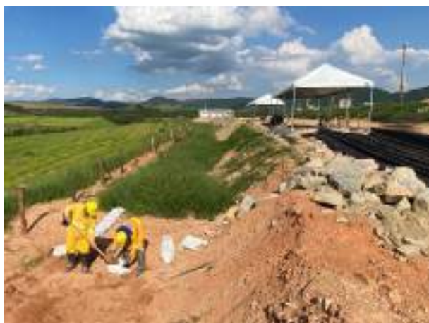
Foto 295 – Implantação de barreiras tipo rip rap (Data:06/12/2021)
