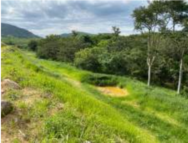
Foto 270 – Vista para a cacimba de retenção de sólidos com vegetação estabelecida na borda. (Data:29/11/2021).
