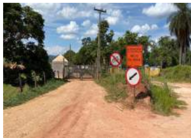
Foto 196 – Via municipal de acesso a obra. (Data:12/11/2021)
