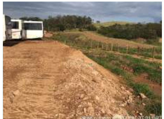
Foto 301 – Talude, leira e gramíneas, vista Leste face norte. (Data:26/10/2021)
