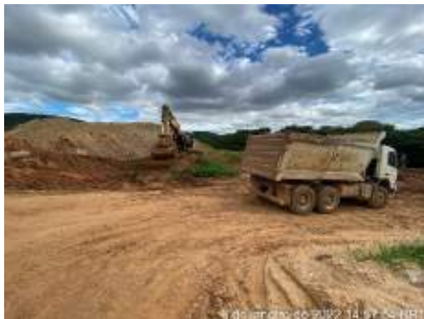
Foto 113 – Movimentação de terra Bota fora. (Data:08/01/2022)
