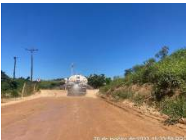
Foto 350 – Umectação de vias internas. (Data:20/01/2022)
