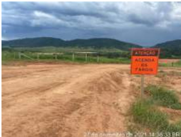
Foto 205 – Sinalização do acesso interno da Obra. (Data: 27/12/2021)
