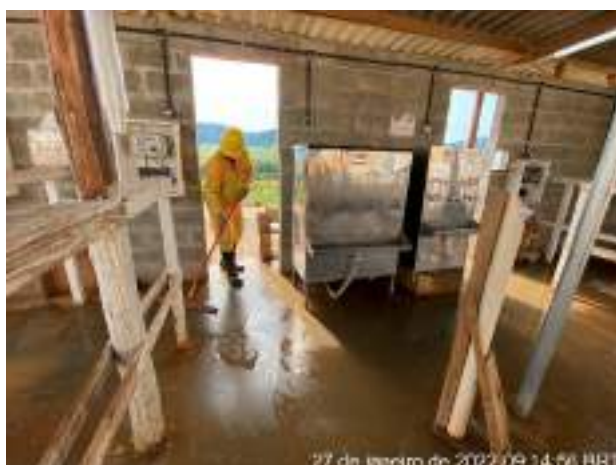
Foto 117 – Limpeza da área de vivência no canteiro industrial. (Data:27/01/2022)
