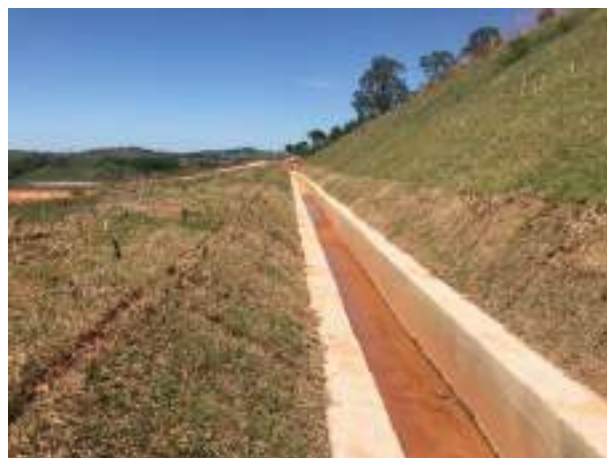
Foto 292 – canaleta de drenagem. (Data:15/11/2021)
