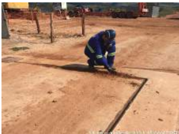
Foto 316 – Limpeza da canaletas do tanque de combustível. (Data: 21/10/2021)
