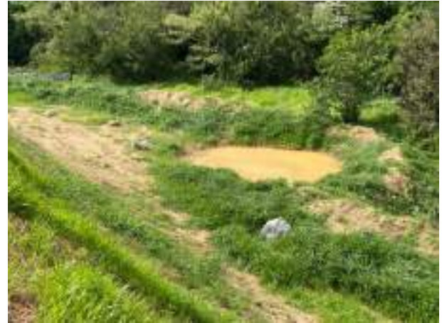
Foto 271 – Vista para a cacimba de retenção de sólidos com vegetação estabelecida na borda. (Data: 29/11/2021)
