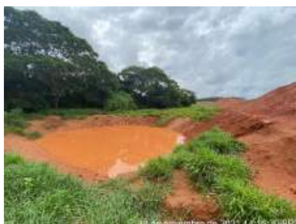
Foto 217 – Cacimba de retenção de particulado. (Data: 30/11/2021)
