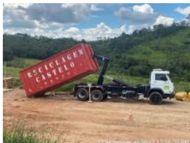
Foto 383 – Troca da caçamba de resíduo de madeira do canteiro industrial. (Data:17/01/2022).
