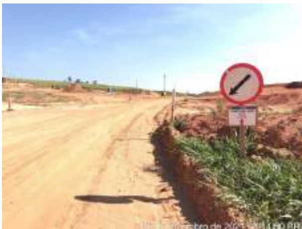
Foto 203 – Sinalização do acesso interno da Obra. (Data: 10/11/2021)
