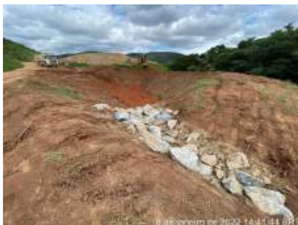
Foto 284 – Vista para a cacimba de retenção de sólidos com vegetação estabelecida na borda. (Data: 08/01/2022)
