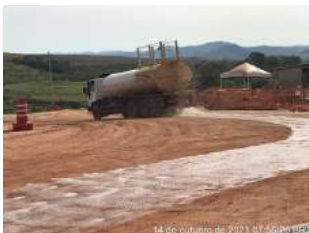
Foto 338 – Umectação de vias internas, Industrial. (Data:14/10/2021)
