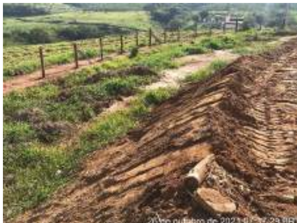
Foto 300 – Talude, leira e gramíneas, vista oeste face norte. (Data:26/10/2021)
