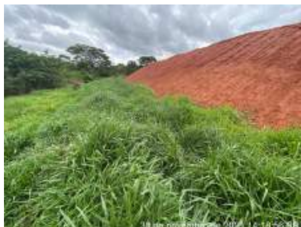
Foto 219 – Canaleta e leira de proteção no entorno do bota espera com inclinação para a saia do talude. (Data:30/11/2021)
