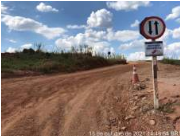
Foto 201 – Sinalização do acesso interno da Obra. (Data: 13/10/2021)
