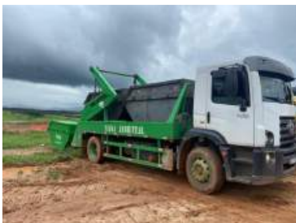
Foto 382 – Troca de caçambas de resíduos do canteiro industrial. (Data:18/01/2022)
