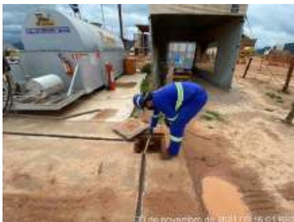
Foto 318 – Limpeza e manutenção das canaletas e Caixa SAO do tanque de combustível. (Data: 30/11/2021)
