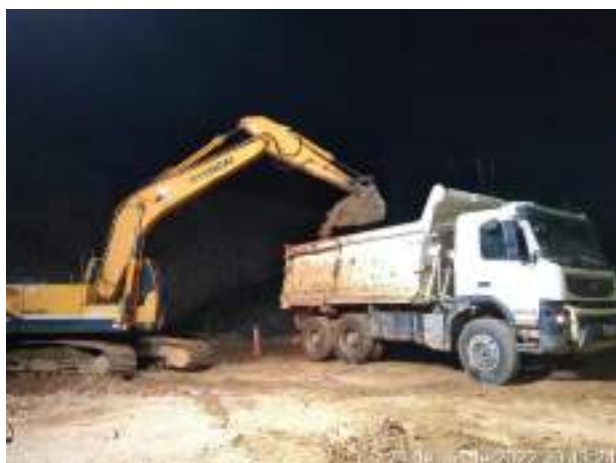
Foto 115 – Escavação Galeria margem esquerda. (Data:21/01/2022)
