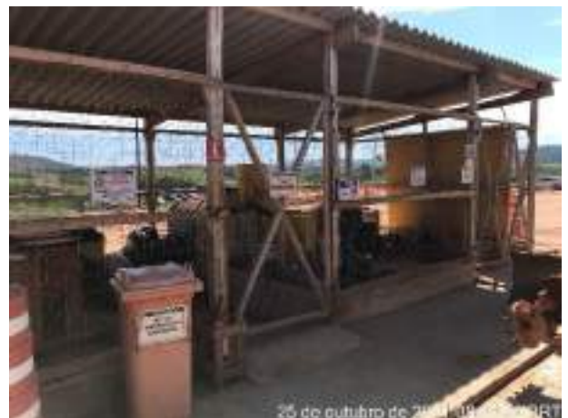
Foto 88 – Baia para armazenamento de produto químico. (Data:25/10/2021)
