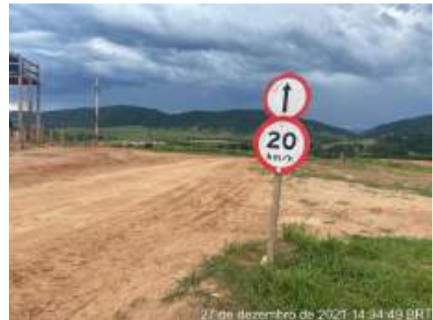
Foto 206 – Sinalização do acesso interno da Obra. (Data: 27/12/2021)
