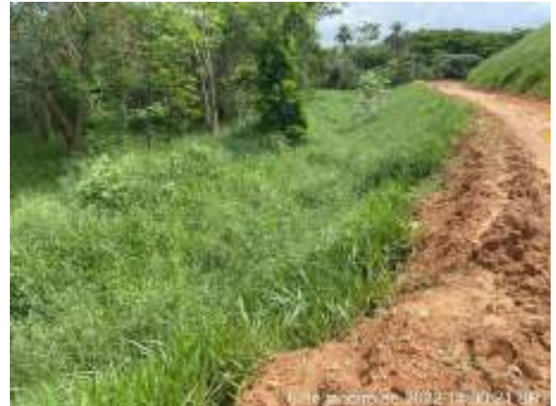
Foto 256 – Material vegetal, leira e canaletão. (Data: 06/01/2022)
