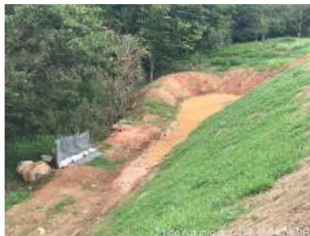
Foto 263 – Vista para barreira silt fence para proteção do corpo d'água. (Data: 21/10/2021)
