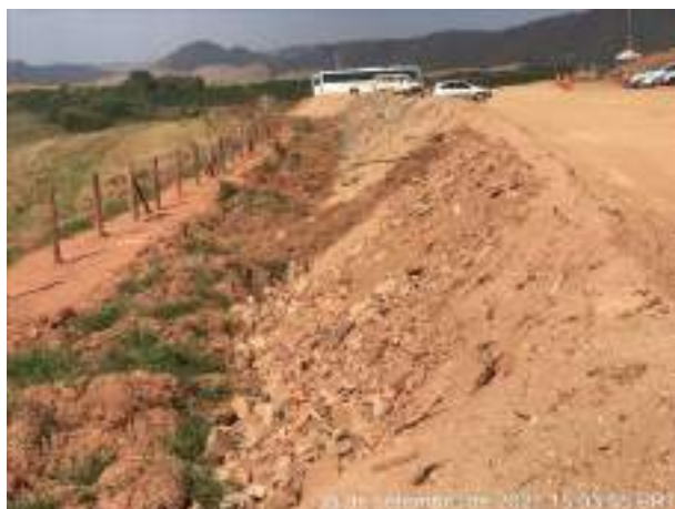
Foto 304 Limite da área do industrial. (Data:30/09/2021)
