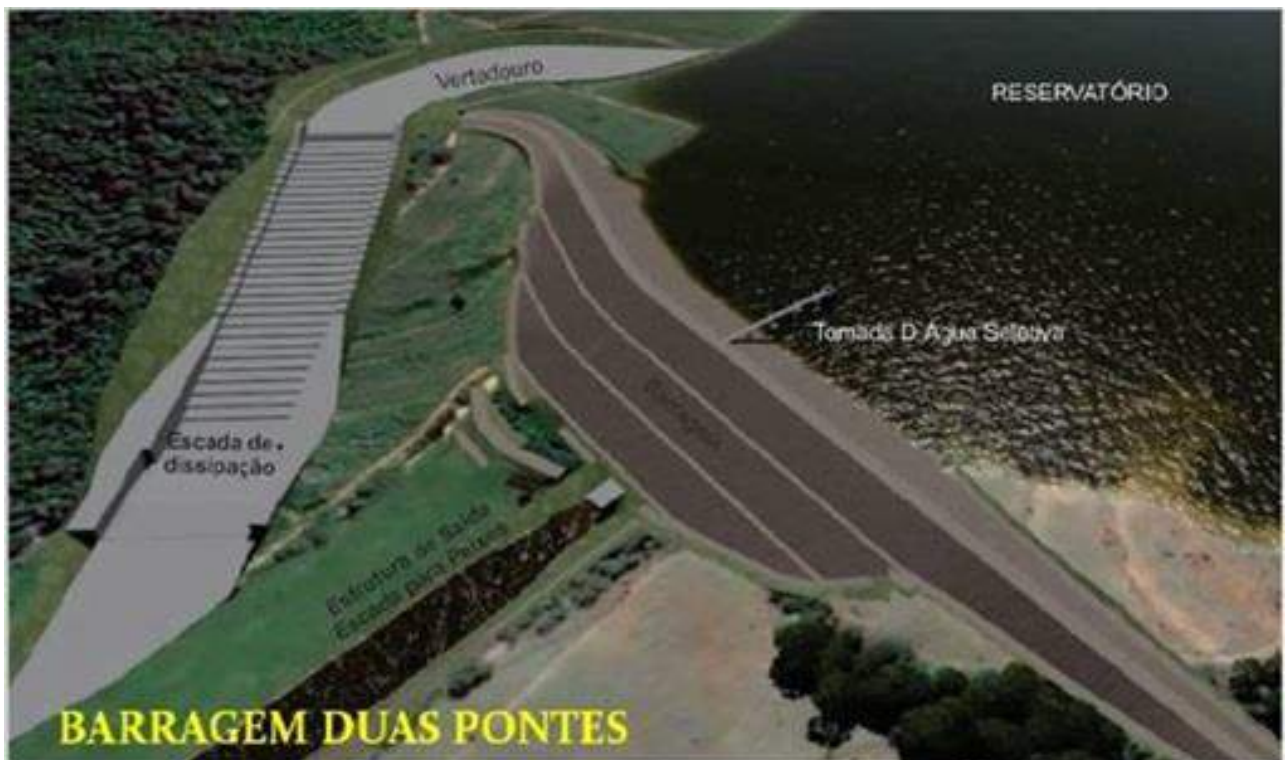
Figura 1 – Projeção da futura Barragem Duas Pontes
