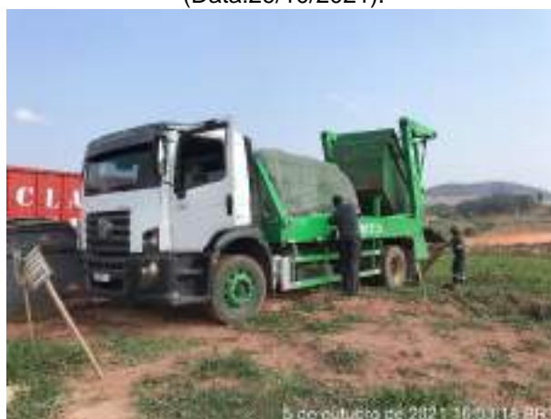
Foto 367 – Troca da caçamba de resíduo comum do canteiro industrial. (Data:05/10/2021)
