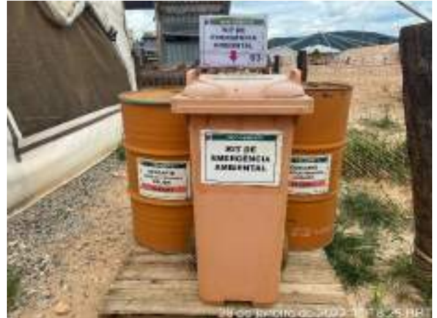
Foto 96 – Kit de atendimento a emergência no Ponto 03, MD Posto de abastecimento. (Data:28/01/2022)
