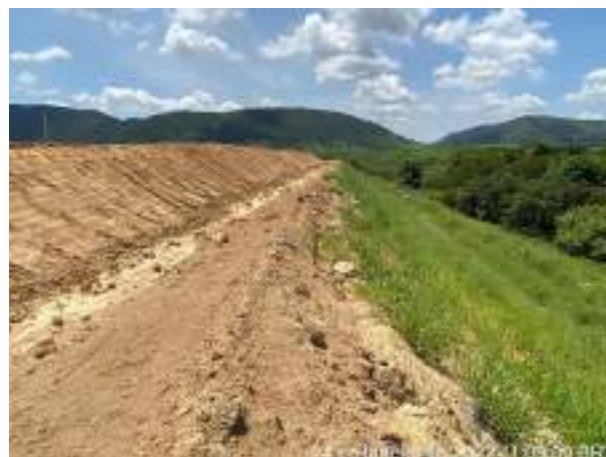
Foto 283 – Vista para compactação do talude, leira e canaletas. (Data: 24/01/2022)
