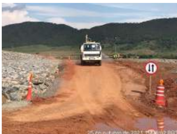
Foto 340 – Umectação das vias internas, MD vertedouro. (Data:25/10/2021)
