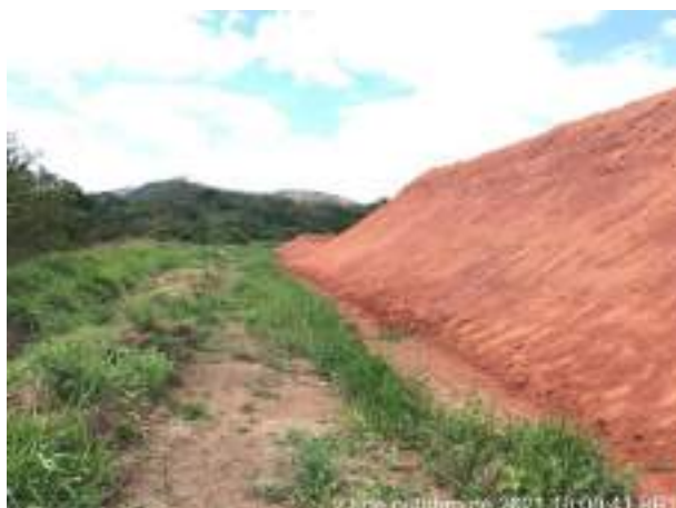
Foto 224 – Canaleta e leira no entorno da bota espera. (Data:21/10/2021)
