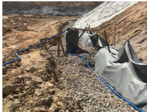
Foto 142 – Dreno com bidim no local de utilização. (Data:20/11/2021)
